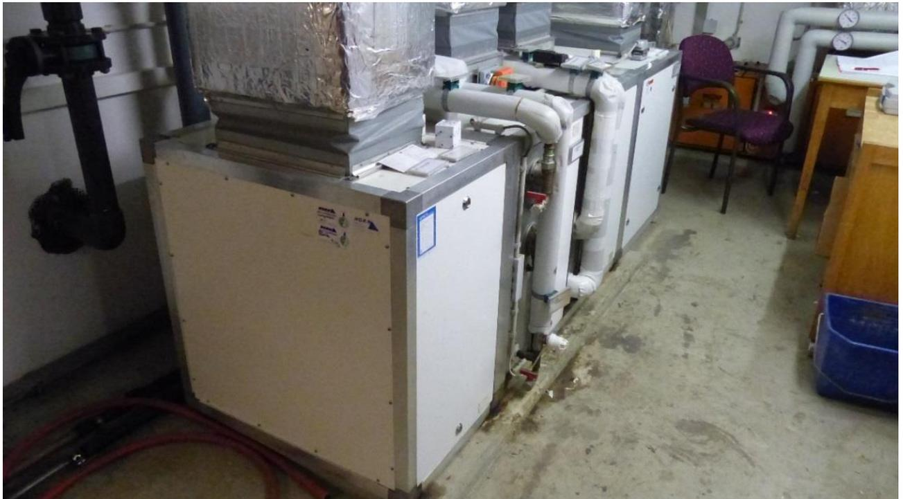
ABBILDUNG 3.20, LÜFTUNGSANLAGE SCHWIMMBAD
