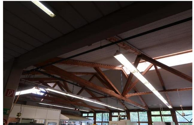
ABBILDUNG 3.16 BELEUCHTUNG BEHINDERTENWERKSTATT ALT (LEUCHTSTOFFFRÖHREN T8)
