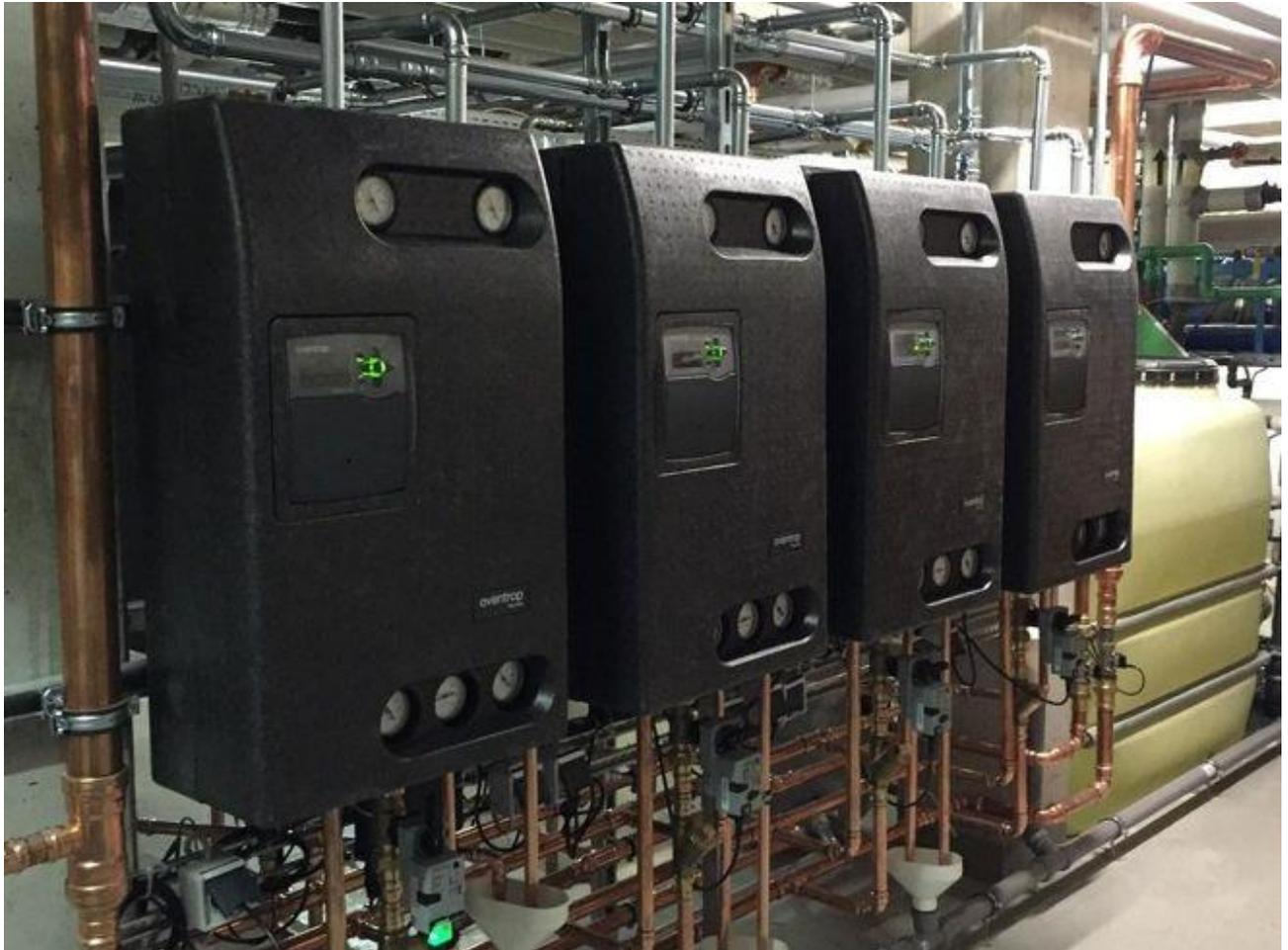
ABBILDUNG 4.12, FRISCHWASSERSTATION, KASKADE<sup>25</sup>
