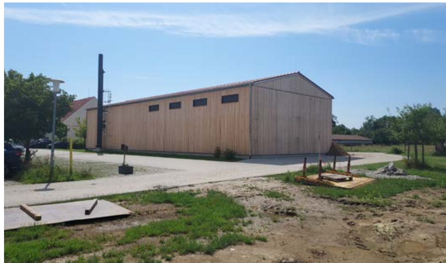
das neue Heizhaus am Zentralparkplatz
