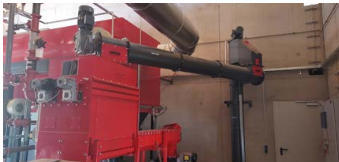
In dem Schwarzen Rohr (rechts) werden die Hackschnitzel zum Ofen geführt
