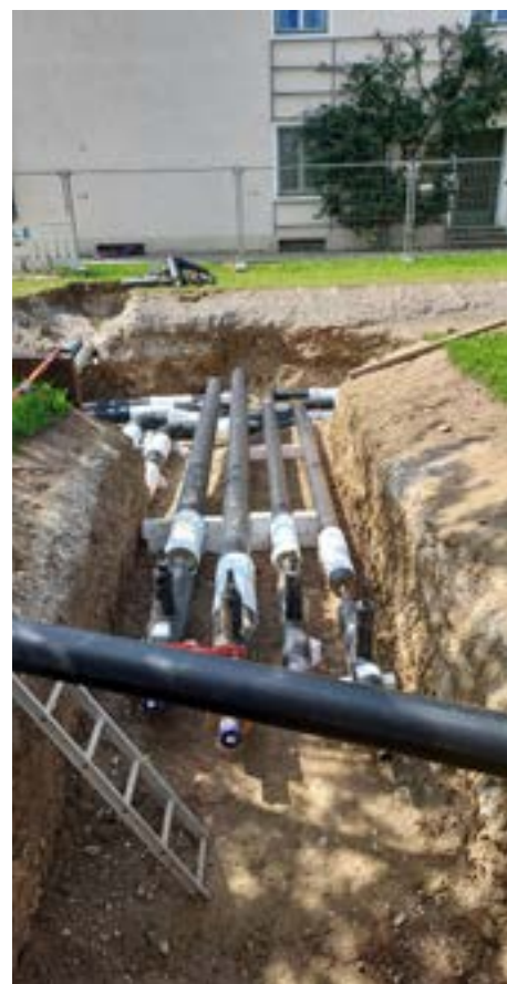
hier sieht man wie die Leitungen verlegt werden
