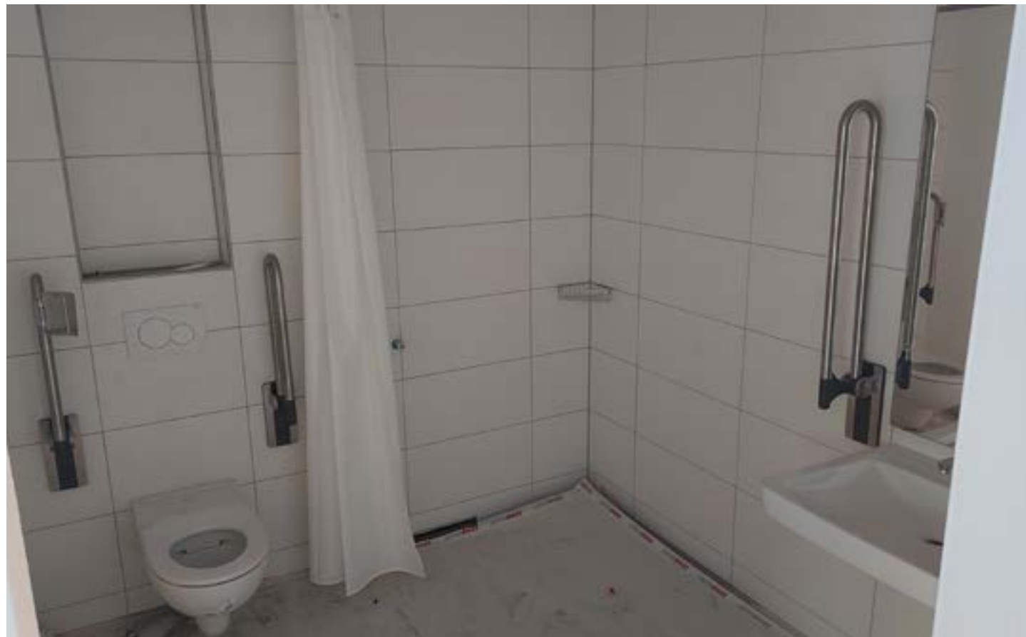
jede Bewohnerin und jeder Bewohner bekommt ein eigenes Bad, Toilette, Waschbecken und der Duschkabine sind bereits eingebaut.
