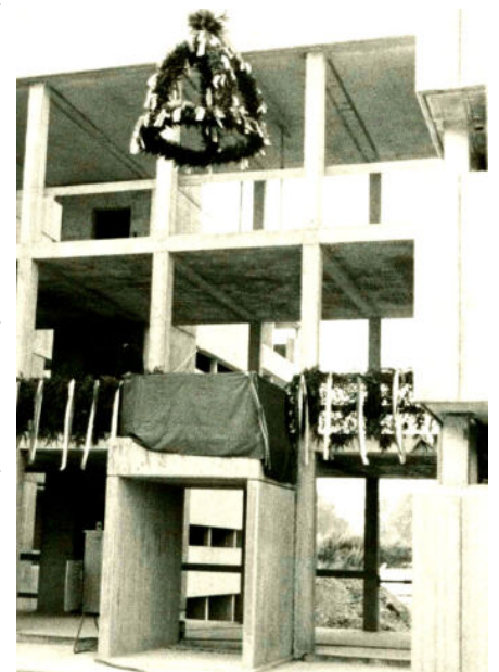
Richtfest von Haus Elisabeth am 22.08.1974 Es zeigt den vielen verbauten Beton
