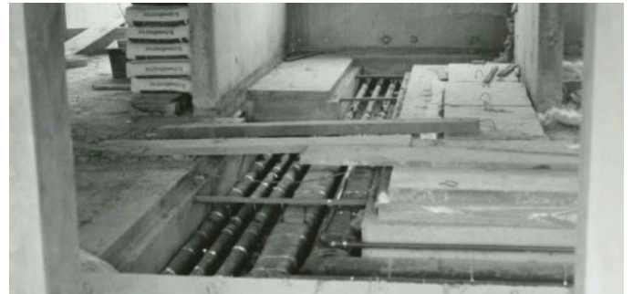
Verlegung der Heizungsrohre
